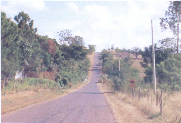
Figura 3: Chegada ao Local de Implantação da ETE pela estrada vicinal ADM 30, sentido Adamantina – Mariápolis.
