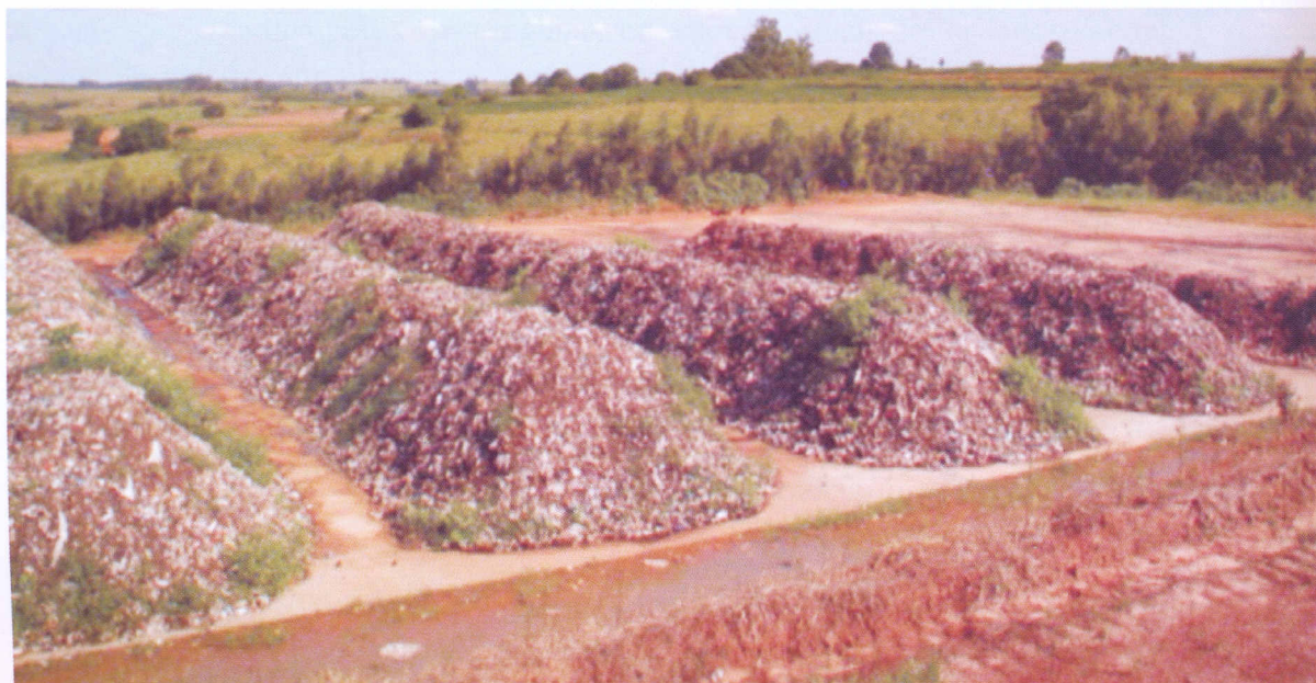
Foto 21: O aterramento de rejeitos em valas.
