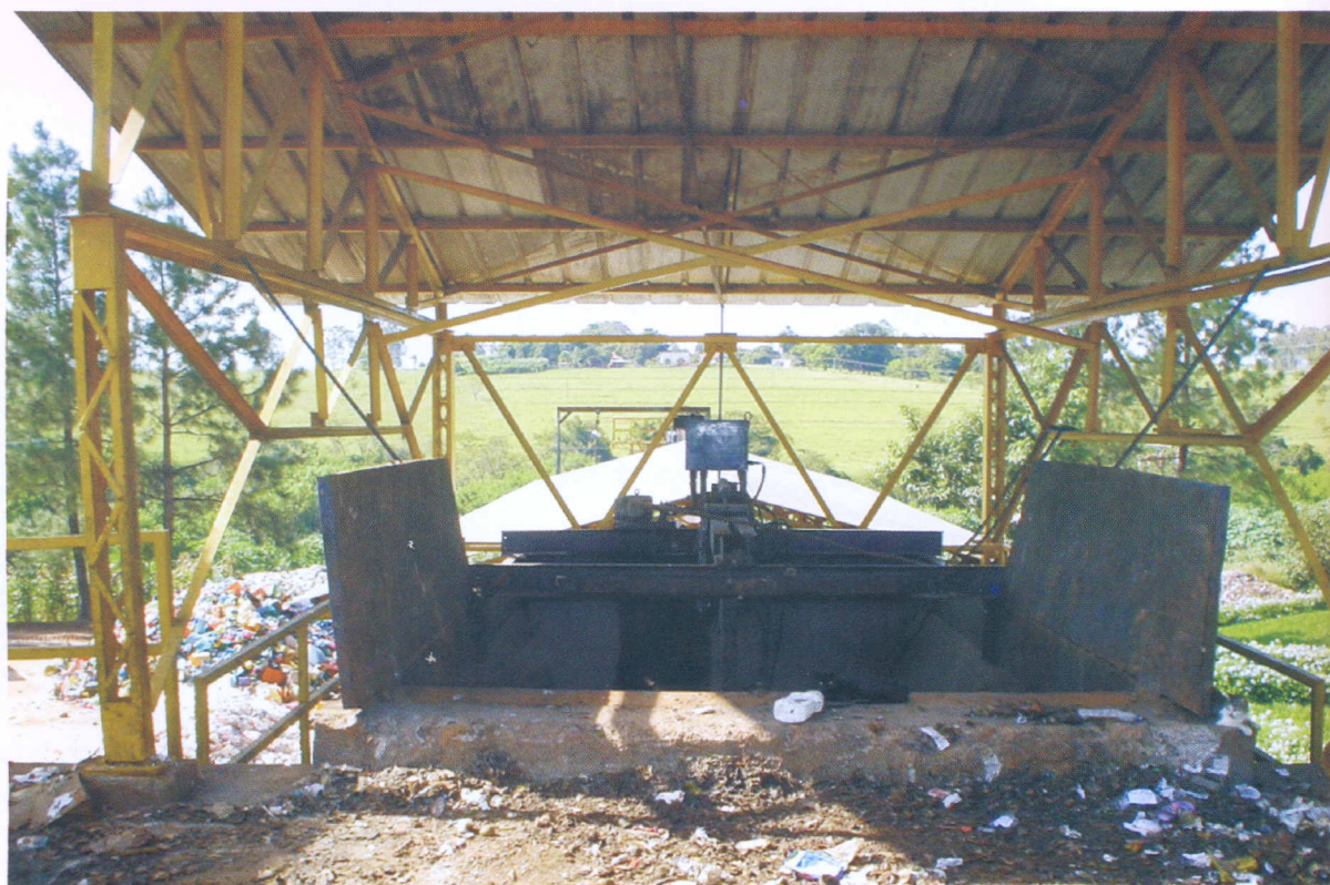
Foto 4 – Inicia-se a alimentação da moega, por meio de pá carregadeira.
