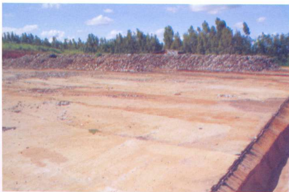
Foto 23: Os líquidos são escoados pela canaleta.
