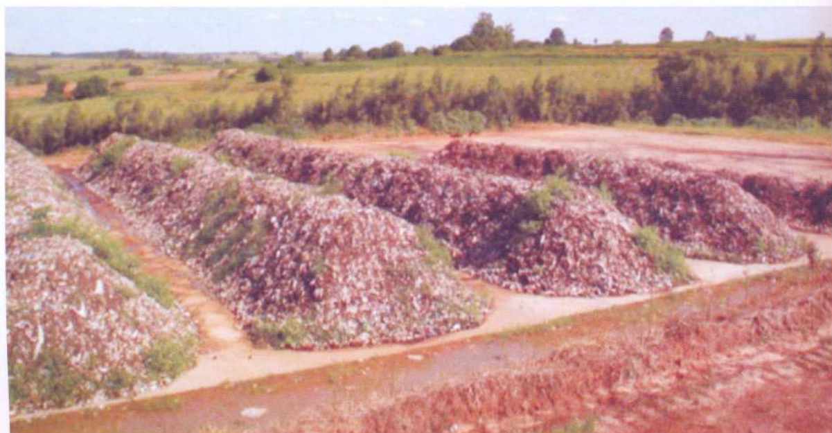
Foto 21: O aterramento de rejeitos em valas.
