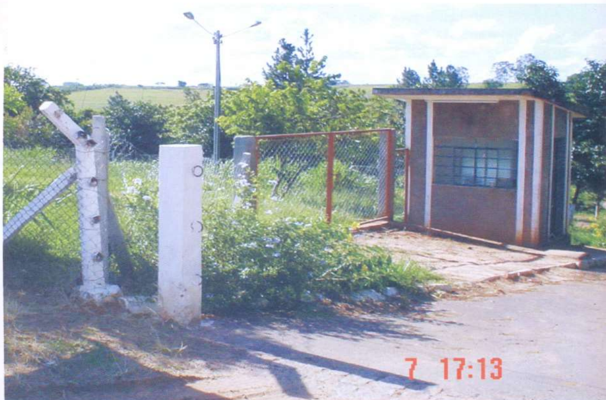
Foto 3: Guarita da atual Usina de Triagem e Reciclagem de Lixo Domiciliar Urbano.
