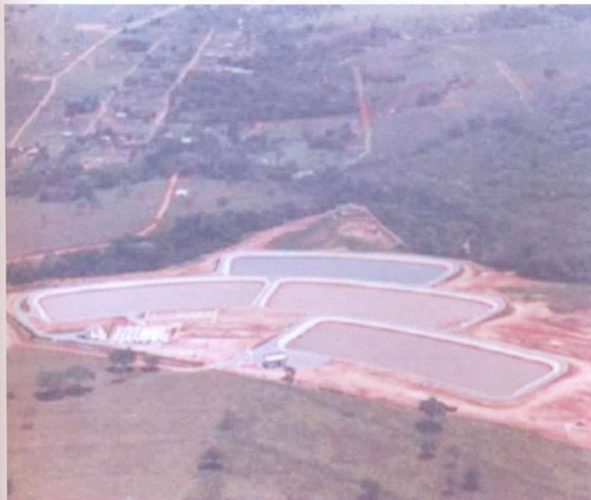
Figura 11: A foto aérea de uma ETE em Lajes, Estado de Goiás.
