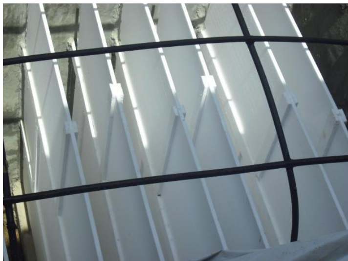
Figura 8: Placas de percolação em poliestireno expandido.
