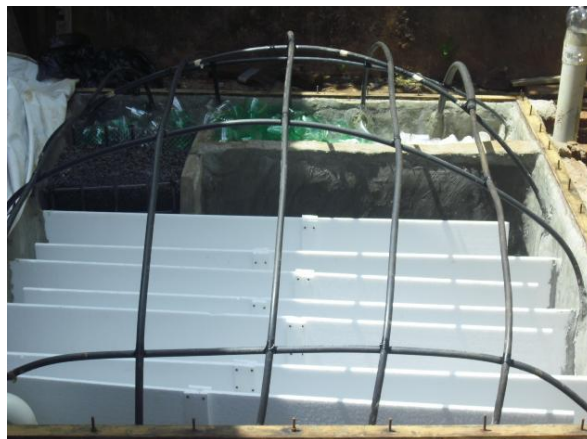
Figura 11: Estrutura de sustentação da geomembrana.
