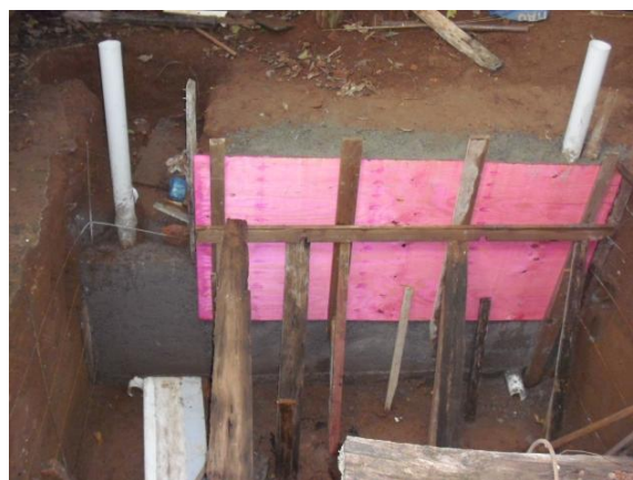
Figura 7: Processo de construção das paredes laterais.
