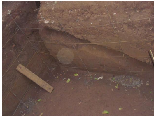
Figura 6: Armação de ferro construída no perímetro interno.
